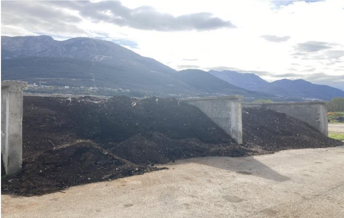
Slika 2.8. Prostor za sazrijevanje i privremeno skladištenje komposta u kompostani Kavač
